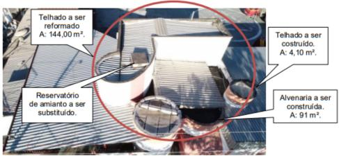
Fotografia 2: Detalhe aéreo do telhado a ser reformado. Fonte: 10° BBM.
